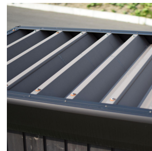
折半屋根 ガルバリウム鋼板
