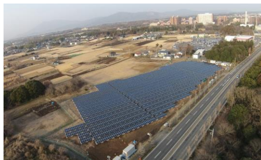
JMESが保有するつくば太陽光発電所
