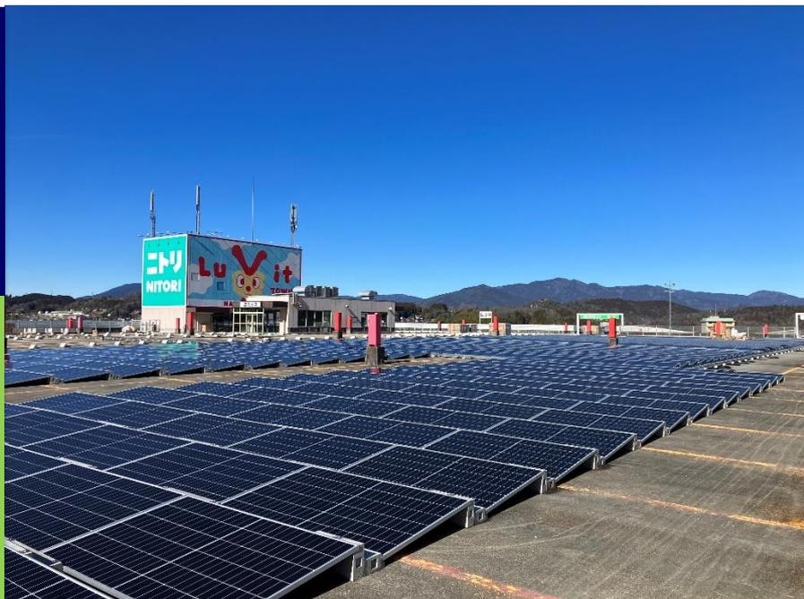
太陽電池モジュール 出力合計:639.625kW(425W×1,505 枚)
